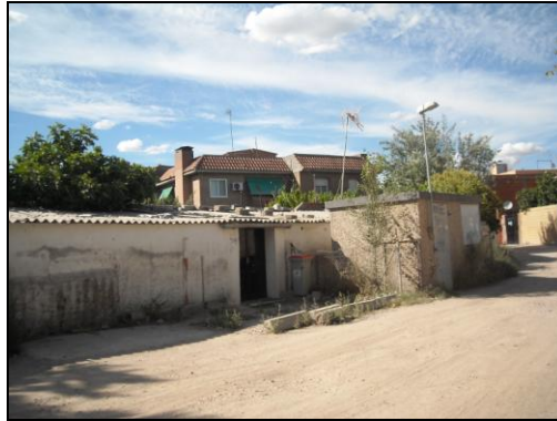
Foto 11: Tramo del Sector 5
