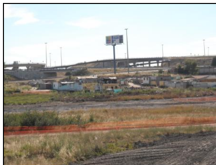
Foto 10: Tramo del sector 5 (chabolas).
