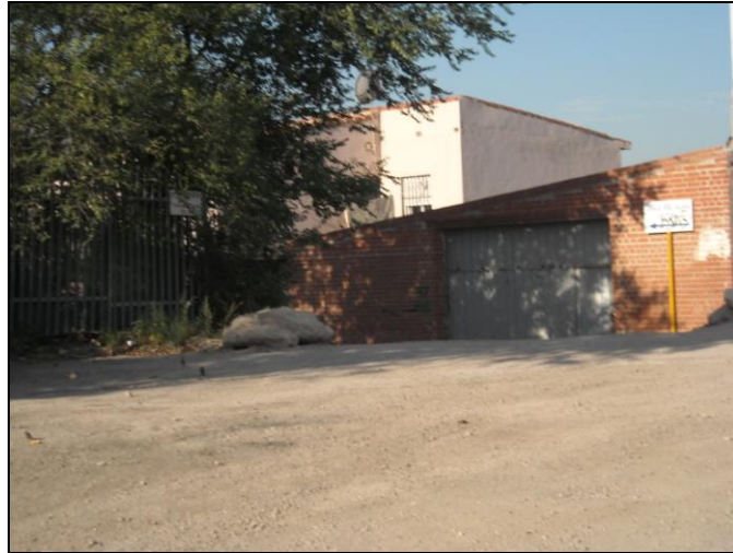
Foto 7: Inicio del Sector 5 a la altura del Camino de la Partija de Rivas-Vaciamadrid hacia el Camino del Santísimo.
